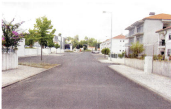
Requalificação da Avenida 25 de Abril
