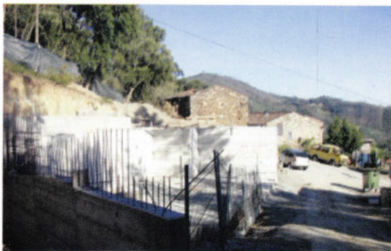
Construção do "Restaurante e Loja da Aldeia" em Casal de S. Simão - Aguda
