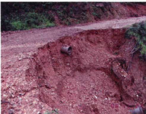
Estrada Vale do Rio - Ribeira da Madre
