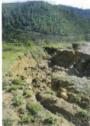
Estrada em Bouçã
