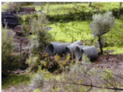
Colocação de manilhas em Foz de Alge
