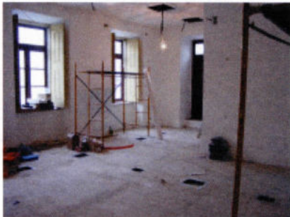
Obras da secretaria municipal em fase de conclusão
