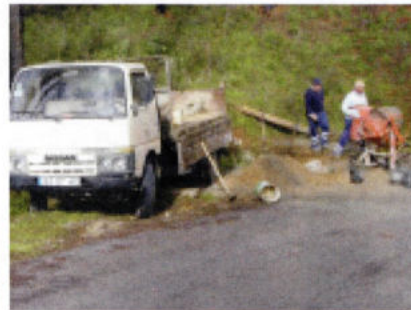
Recuperação de bermas
