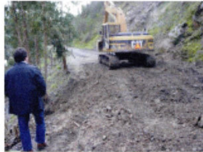
Recuperação de estrada florestal em Foz de Alge
