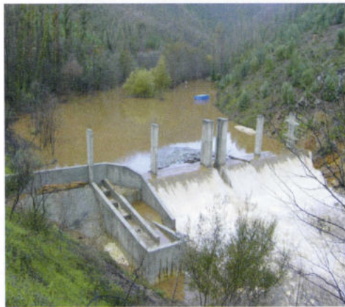
Ponte açude - Poeiro
