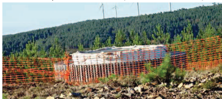
Torre nº 14 na proximidade da estrada florestal 236/Cabeço do Pião
